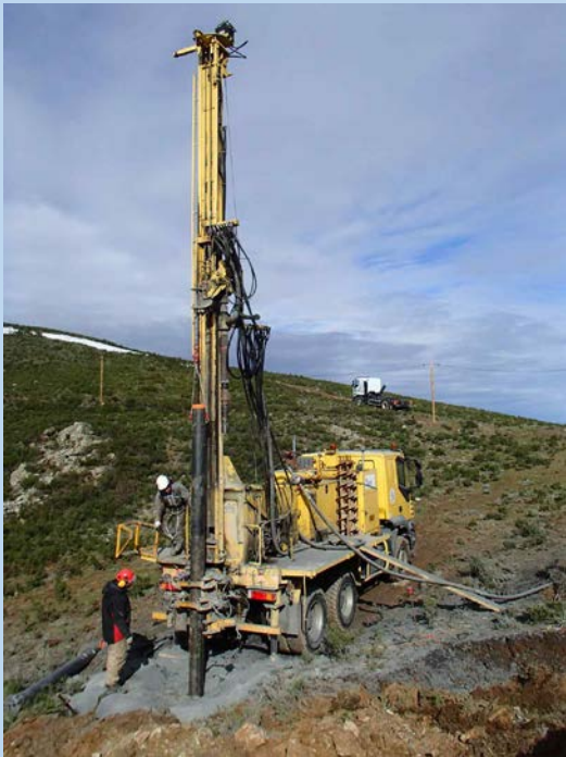
Forage du puits sismo de 8 mètres (BRGM)
