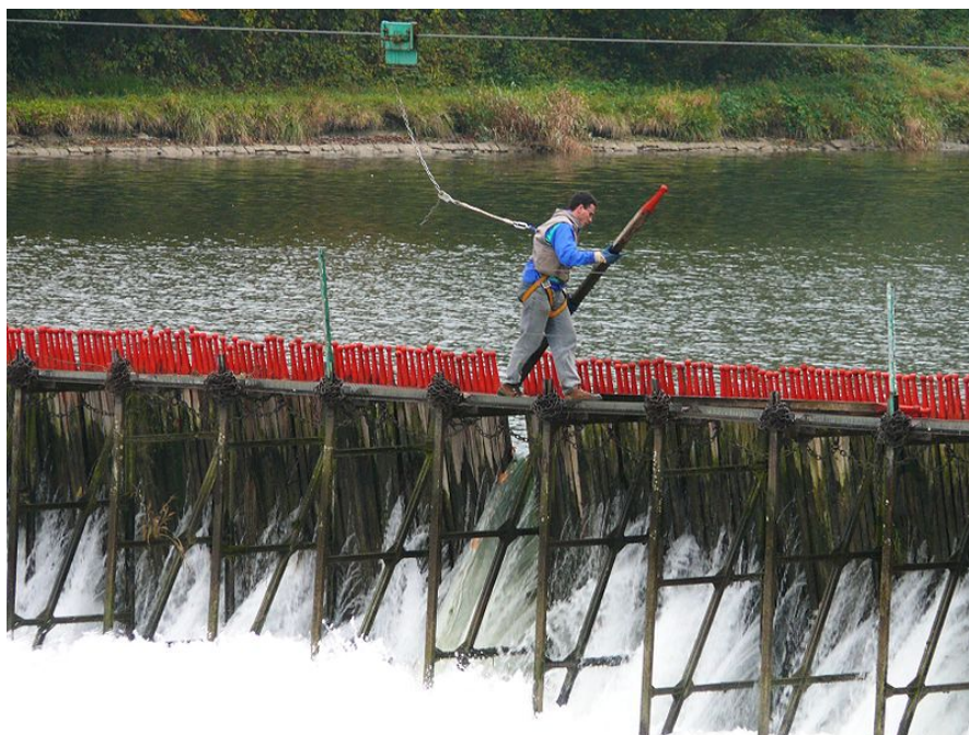
Barrage à aiguilles
