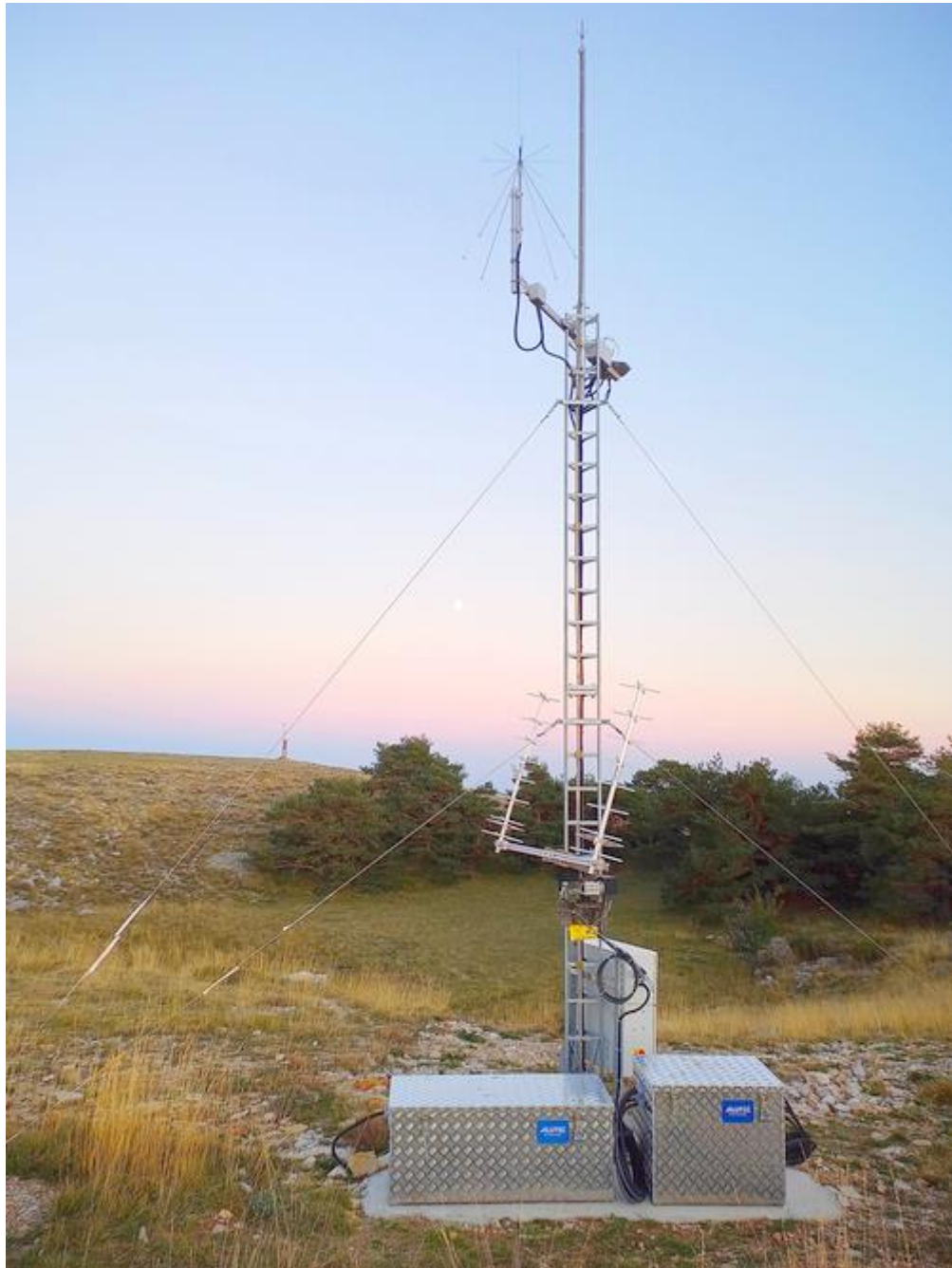
La station radio à Calern en octobre 2023.
