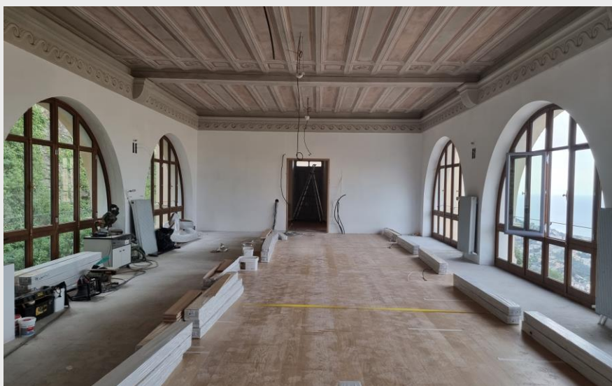
La pose des fenêtres est terminée, celle du parquet est en cours
